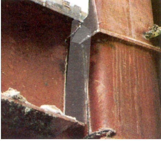
Resim 4. Kolonun köşe kaynaklı bölümünde kırılma (Kobe depremi sonrası)
