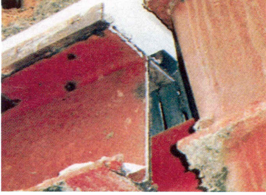
Resim 6. Bir köprünün çelik kolonu üzerinde gevrek kırılma (Kobe depremi sonrası)
