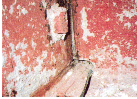
Resim 7. Bir köprünün döküm kolonunda gevrek kırılma (Kobe depremi sonrası)
